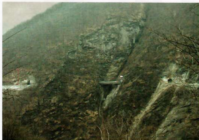
Abb. 2: Die alte Straße querte beide Felsrippen mit 2 Tunneln, welche die Brücke Val d'Infern verband
