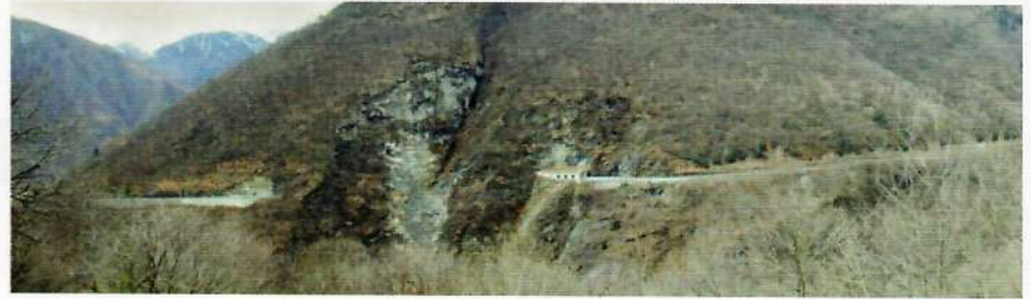
Abb. 1: Der heutige Tunnel umfährt beide Felsrippen und dazwischen den später abgefahrenen Felssturz
