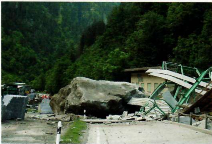
Abb. 13: Ein 350-m 3 -Block sperrte die Straße definitiv
