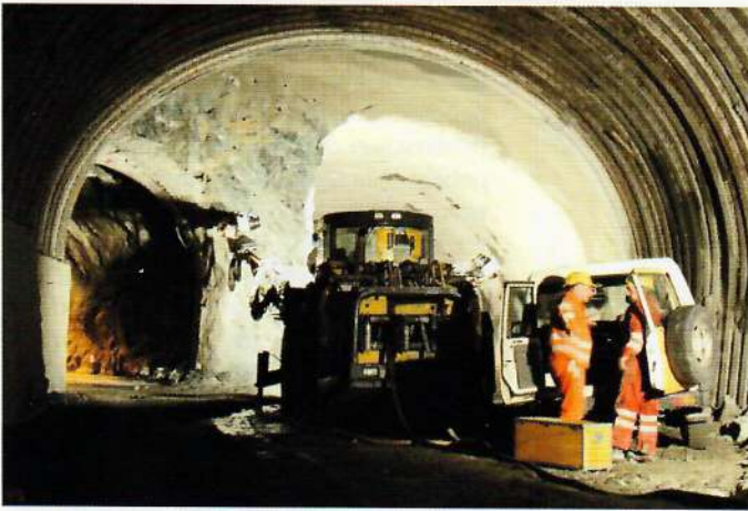
Abb. 6: Das Verzweigungsbauwerk beider Tunnel
