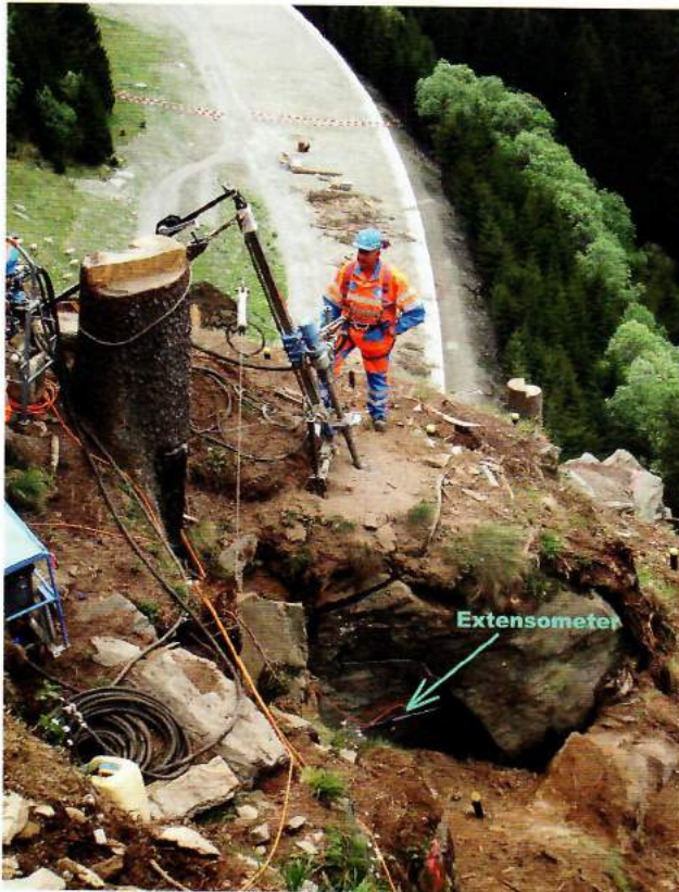
8: Sprenglochbohrung in der unteren Felschuppe werden abgetieft. Im Vordergrund ein Extensometer der Felsüberwachung.
