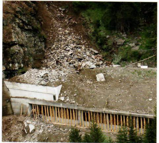
10: Die Galerie Cozz übersteht den Aufprall ohne nennenswerte Schäden.
