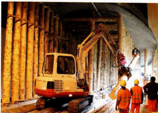
9: Die Galerie wird auf einer Länge von 45 Meter mit Rundholz gespriessst.
