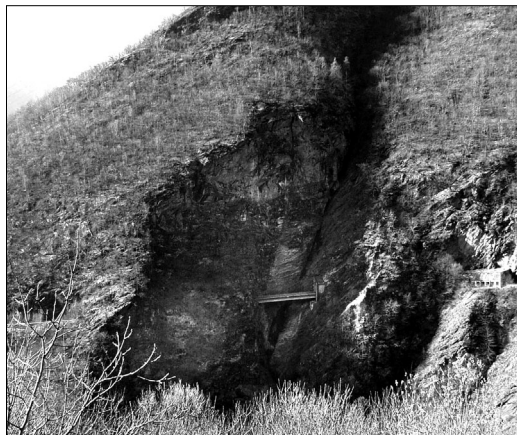
Fig. 1: Die Brücke Val d'Infern als Verbindung zweier Tunnel quert eine geologische Störzone.
