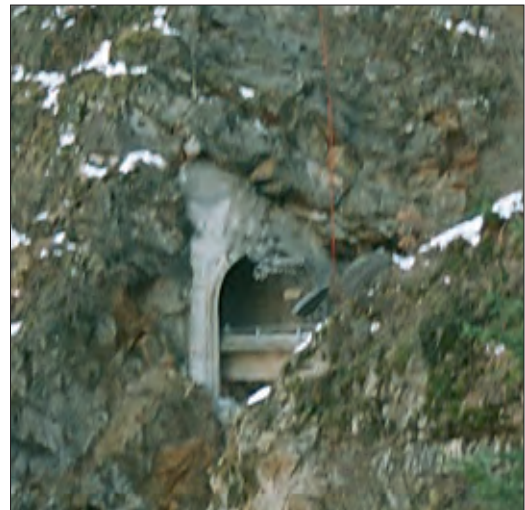
Fig. 7: Das Tunnelportal wurde innerhalb der letzten 3 Stunden stark deformiert (Zeitpunkt vor dem Absturz: oben links 2\frac{3}{4} h, oben rechts 1\frac{1}{2} h, unten links \frac{3}{4} h, unten rechts \frac{1}{2} h).
