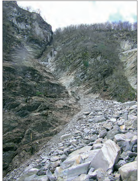
Fig. 11: Blick von der Calancasca hinauf über den Schuttkegel ins Tal der Hölle, wo seit dem 3. Februar 2006 die Brücke fehlt.
